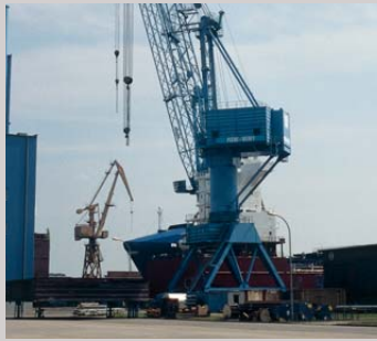
Hafenkrane Dockside Cranes
