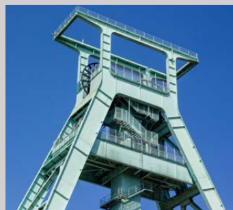
Untertagebau Underground Mining
