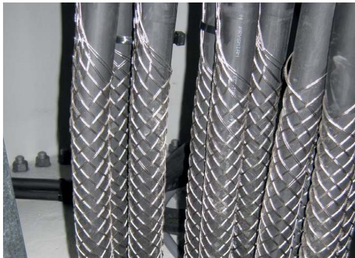
**CondorGrip Kabelhaltestrumpf (speziell für Windkrafttürme), Typ KW I-K, verzinkt, Doppelgeflecht, beidseits offen, einseitig flach extralang ausgeflochtene und angepresste Kausche, Material Litze 1 x 19**
